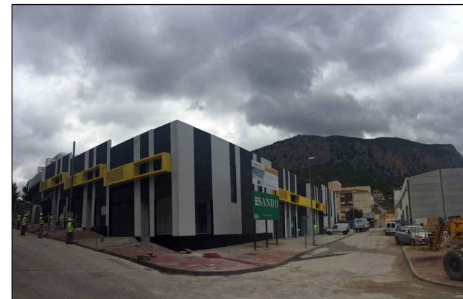
Vista C/ De los Cortadores esquina C/ Cámara de Comercio
