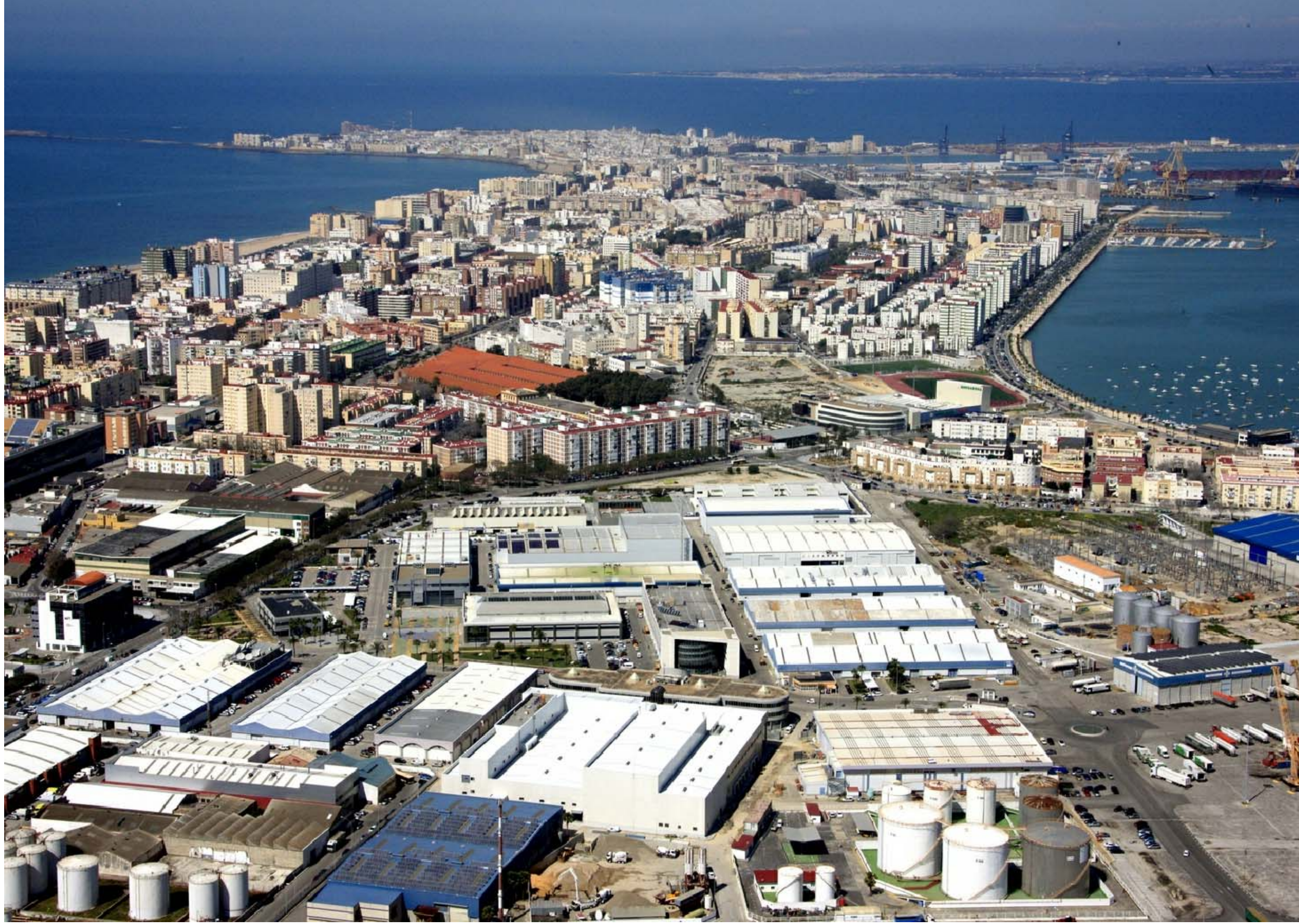
NAVE FRIGORÍFICA PARA MANIPULACION Y ENVASADO DE PRODUCTOS DEL MAR RECINTO INTERIOR DE LA ZONA FRANCA DE CÁDIZ
